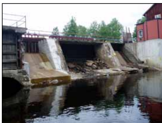
Figur 4. Vattenkraftverk som utgör vandringshinder (tabell 3, hinder 1).
