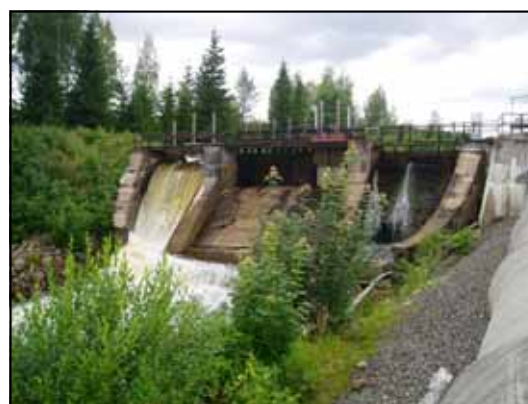
Figur 5. Vattenkraftverk som utgör vandringshinder (tabell 3, hinder 2).
